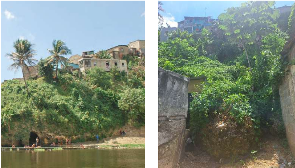
Figura 50 : Fotos de ejemplo cercana a viviendas construidas en las pendientes abruptas a orillas del río Ozama y de un deslizamiento en el sector de La Ribera. Fuente Urbe y propia
