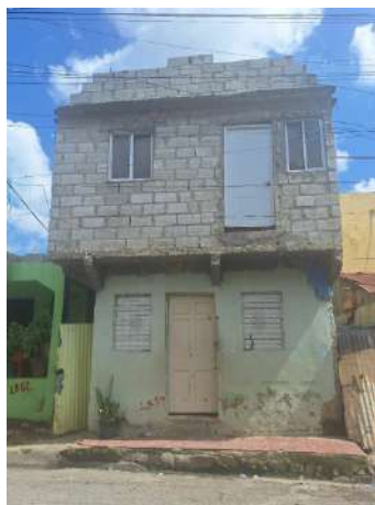
Figura 73: Vivienda de dos niveles construida en dos fases en bloques de hormigón
