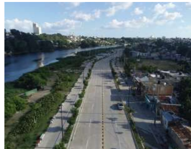
Vía de 4 carriles sobredimensionada en Nuevo Domingo Savio.
