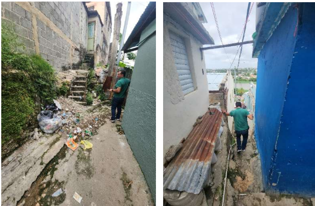
Figura 52 : Fotos de zonas sin drenajes pluviales, donde el agua corre por las pendientes y escaleras durante los eventos de lluvia (se observan claramente las marcas de escorrentía). Fuente: propia
