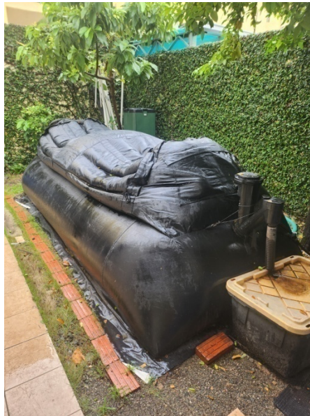
Ilustración 15: Ejemplo de biodigester en Santo Domingo (Fuente: ECO-INVENTAGRI)
