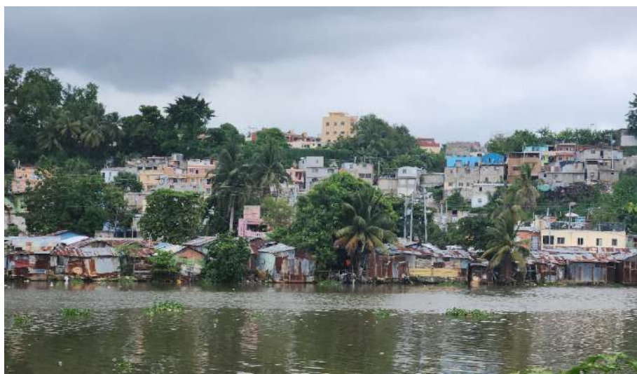
Figura 20 : Viviendas en la ribera del río a menos de 50 cm sobre el nivel del mar en las Lilas. Fuente: propia
