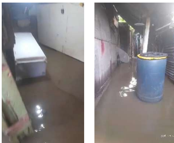
Figura 23 : Fotos de la inundación de noviembre 2023 en el sector de las Lilas en algunas viviendas del borde del río. Fuente: un habitante de las Lilas
