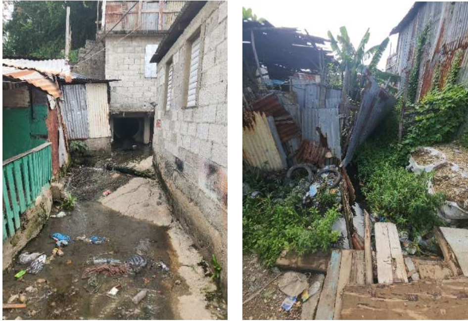
Figura 18 : Fotos de drenajes pluviales sobre los cuales o justo al lado de los cuales se han construido viviendas en las Lilas. Fuente: propia
