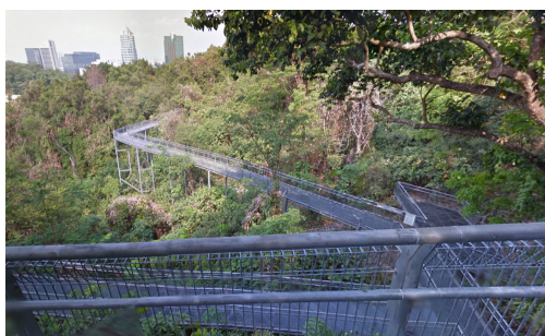
Rampas y pasarelas que permiten una continuidad de desplazamiento a pesar de pendientes importantes.
